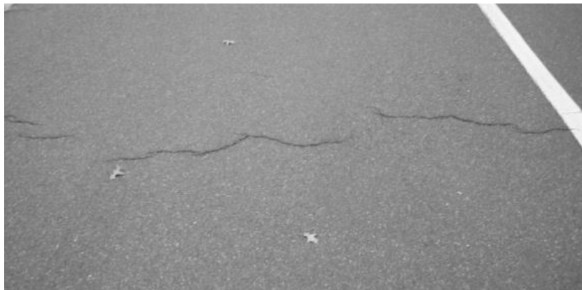
Figura 3. 9 Agrietamiento transversal.
