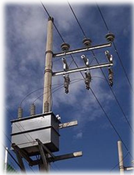
Figura 1.4.- Representación de un centro de transformación. Fuente.(www.cfe.gob.mx).
