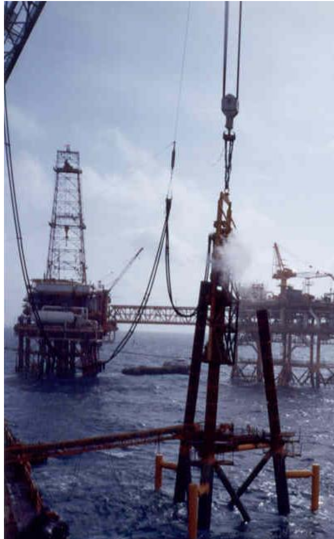
Fig. 1.5 Hincado de pilotes (Ibarra y Luna, 2000)
