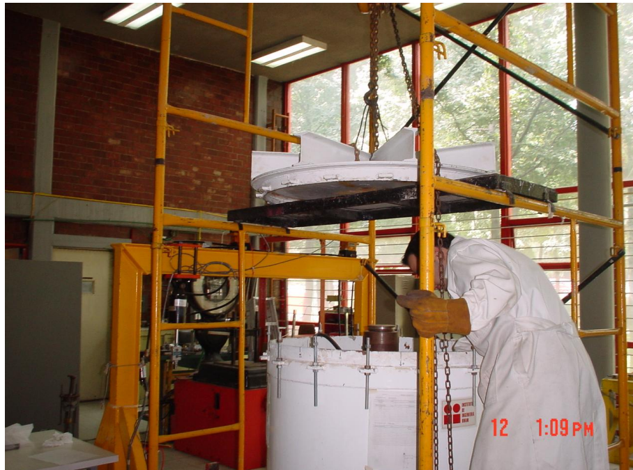
Fig. 3.17 Elevación de la tapa reforzada del odómetro.
