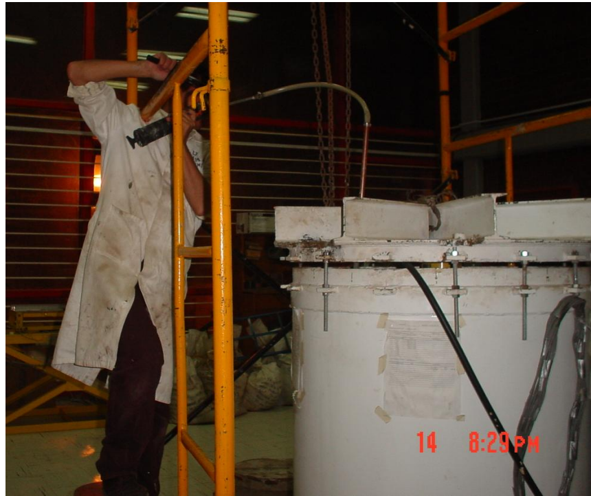
Fig. 3.22 Inyección de la mezcla en el hueco.
