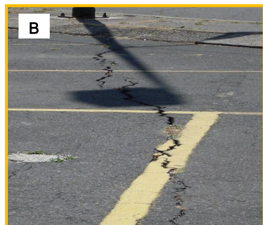
Figura 4.2 Daños en la carpeta asfáltica de la U.H. Rinconada del Sur. A) Agrietamiento de relevo y B) Agrietamiento simple. Fuente: SPC del DF.
