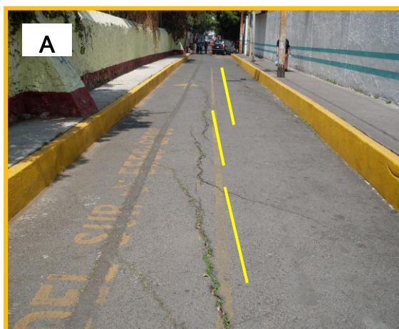
Figura 4.2 Daños en la carpeta asfáltica de la U.H. Rinconada del Sur. A) Agrietamiento de relevo y B) Agrietamiento simple. Fuente: SPC del DF.
