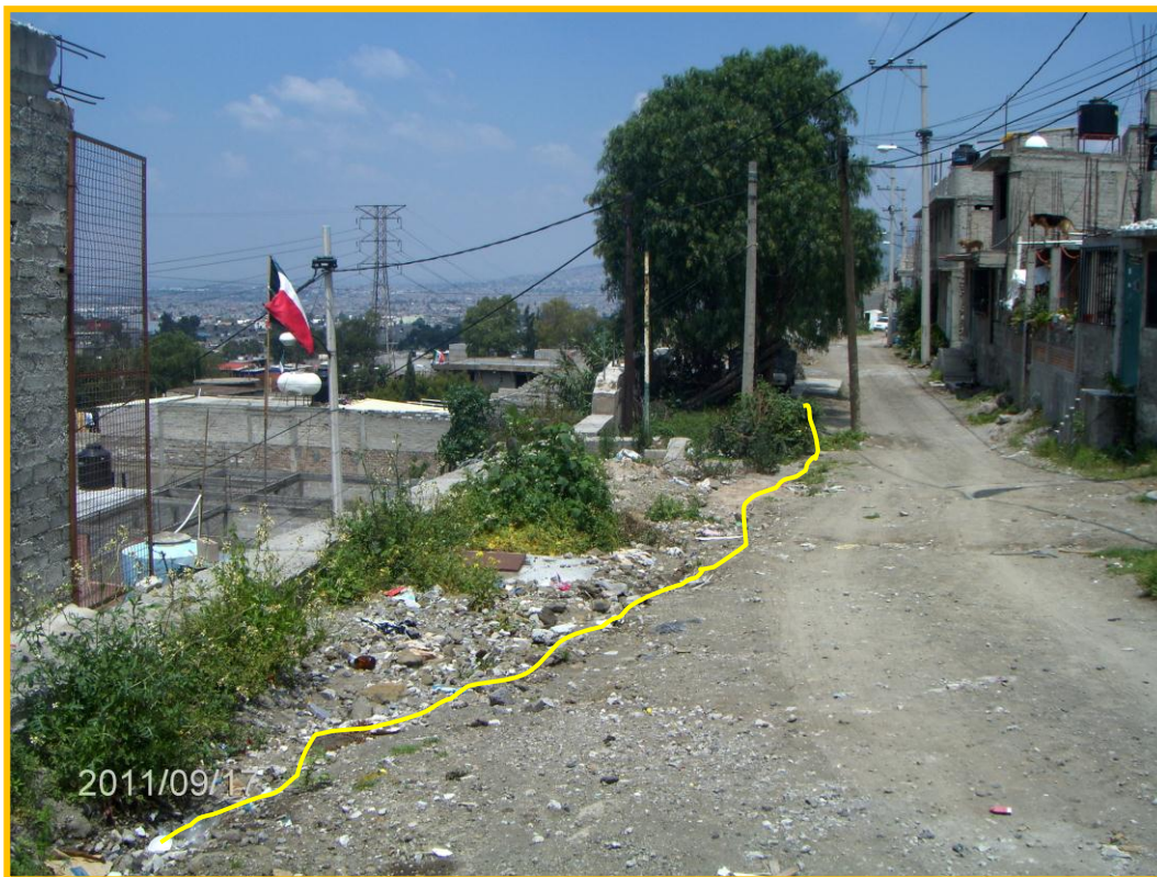
Figura 5.12 Agrietamiento asociado a un PRM, ubicado al piedemonte.
