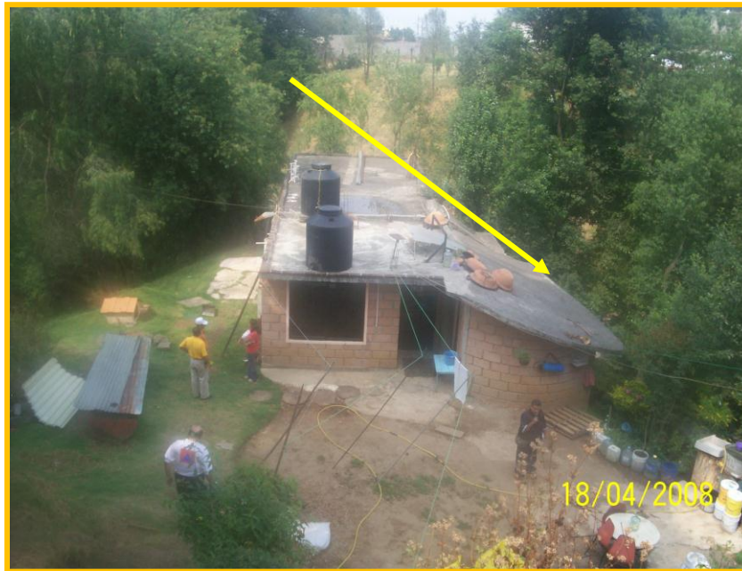
Figura 3.9 Vivienda afectada debido a su localización esta en las orillas de la Barranca Juárez, Álvaro Obregón. Fuente: SPC del DF.
