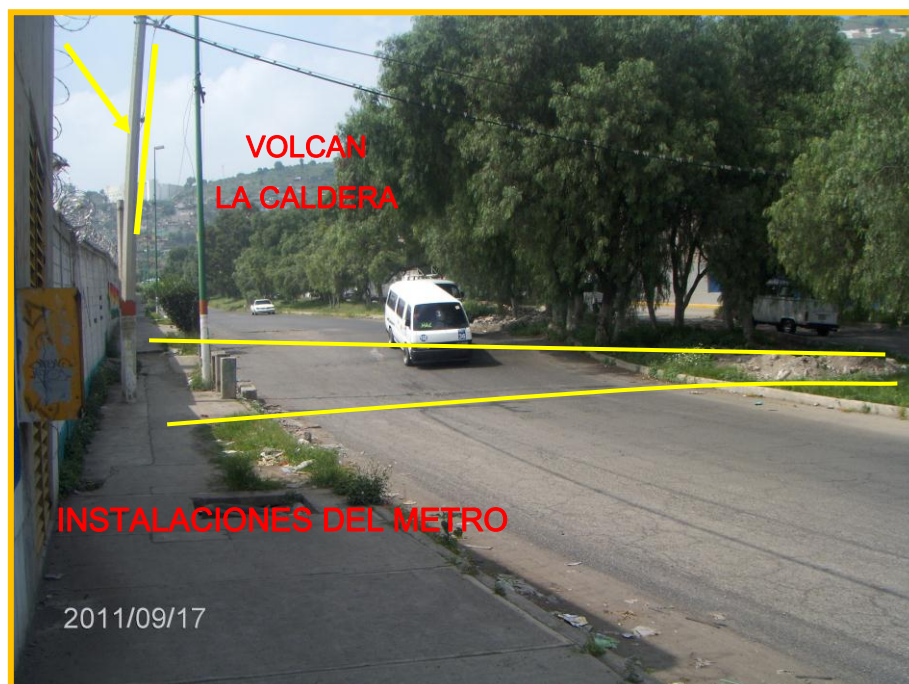
Figura 4.9 Agrietamiento y daños a la infraestructura civil e instalaciones del metro ligero (estación La Paz).
